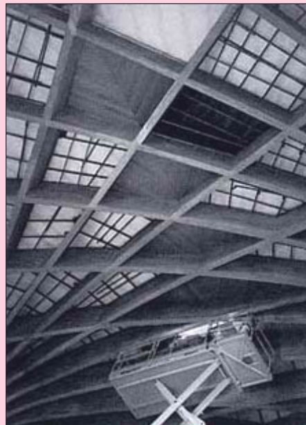
Un particolare dell'applicazione dei listelli di legno nei rombi del soffitto della chiesa
