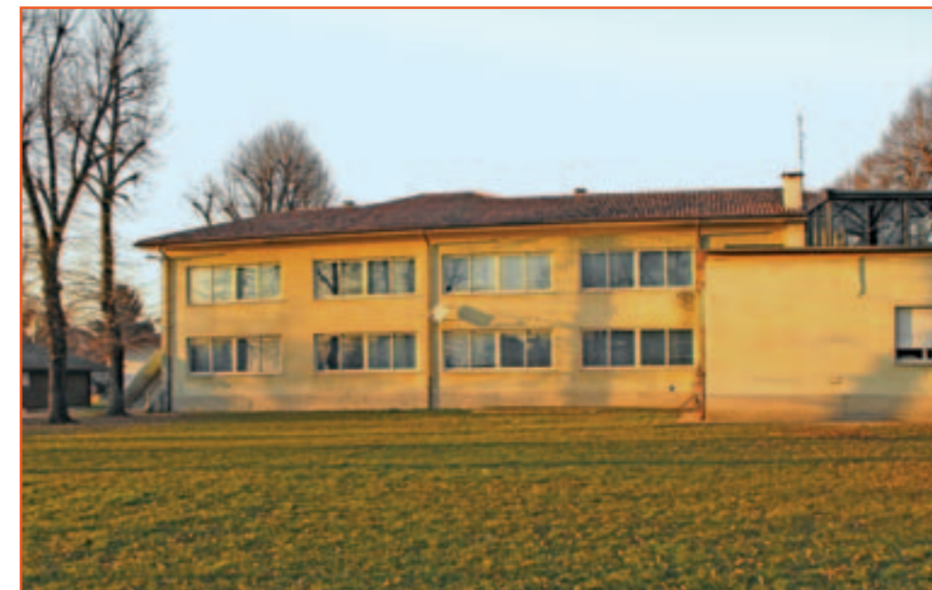
Il lato della scuola soggetto ad interventi
