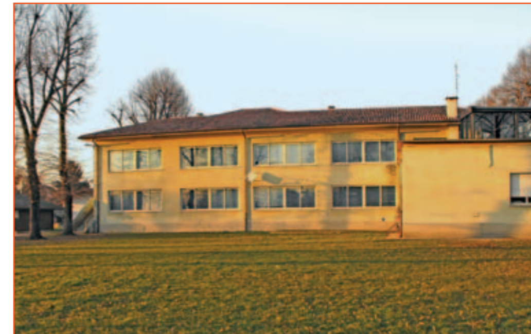
Il lato della scuola soggetto ad interventi
